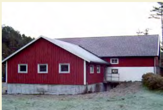
Tilbygg som er bygd opp fra grunnen av. Foto: Alf Gunnar Nøkland
