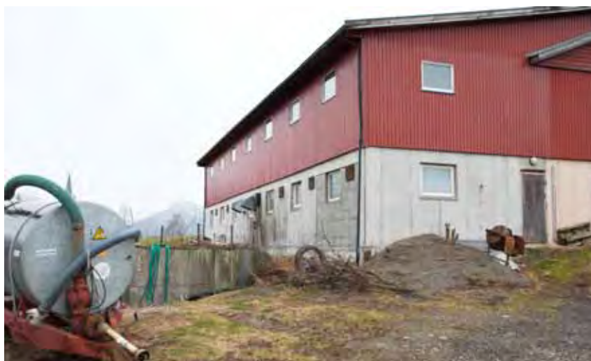
– Som bønder er vi heile tida i ein utbyggingsfase, fortel Arne Einar. Her ser vi siste byggetrinn på grisehuset.
