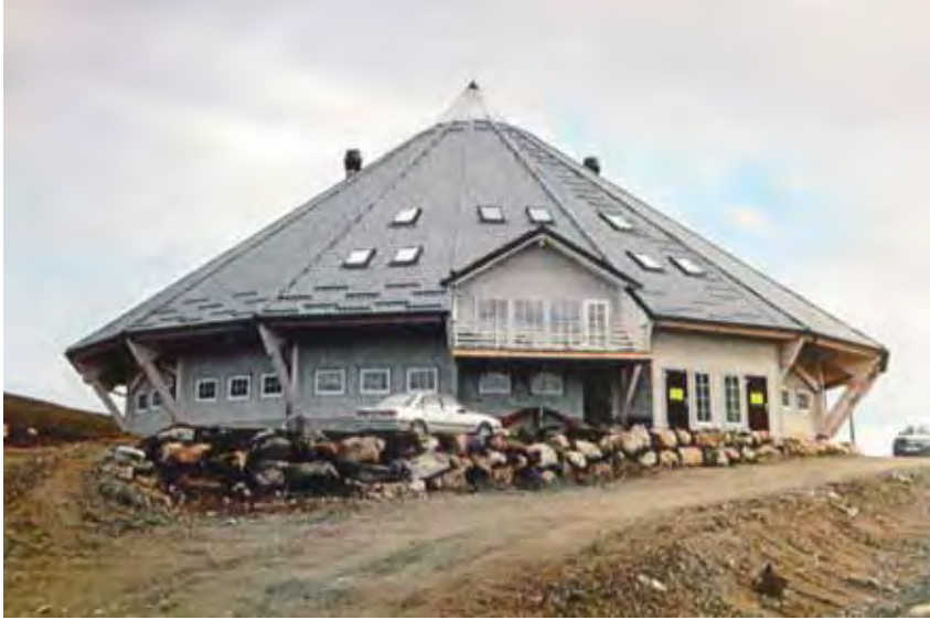
Barentsfjøset i Karlsøy (s.80). Grunnplanen er nær sirkelformet og bonden bor i andre høgda.
