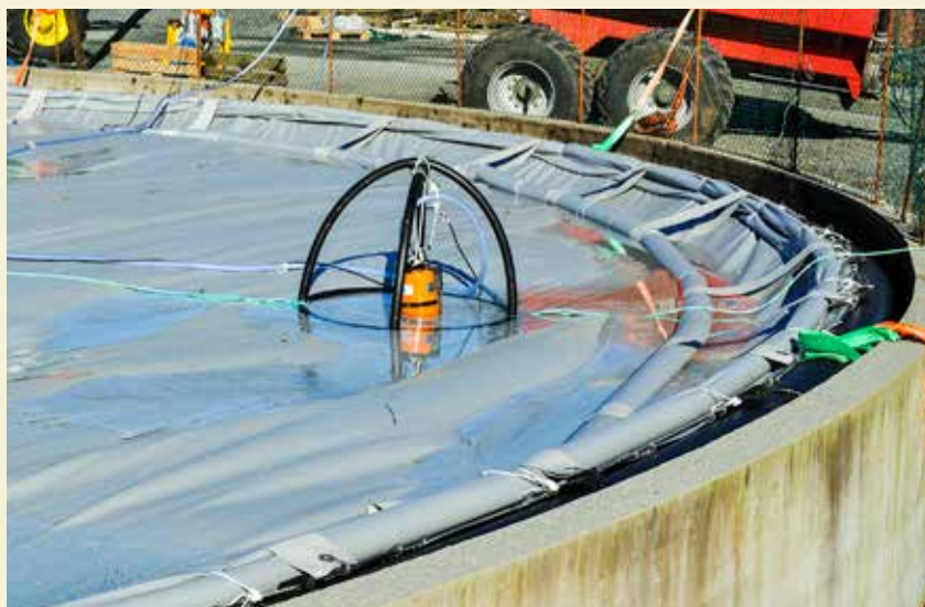
Flytedekke som leggst opp på gjødsla for oppsamling og utpumping av nedbør.
