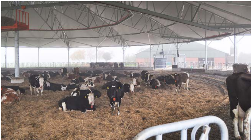
Rundfjøset har et 3 meter bredt spaltegulv bak fjørhekken, og med talle i midtarealet. 138 eteplasser, med 1 meter avstand mellom hver, gir plass til alle kyrne uansett rang. Skinnegående strøkutteapparat i taket.
